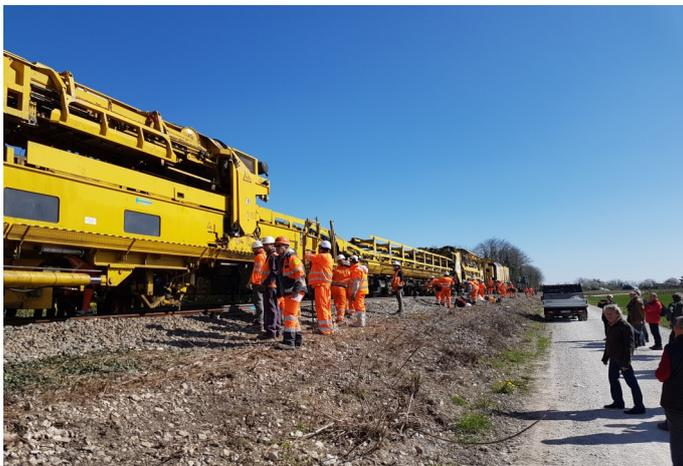
**T**rain usine pour la réfection de la voie ferrée.
