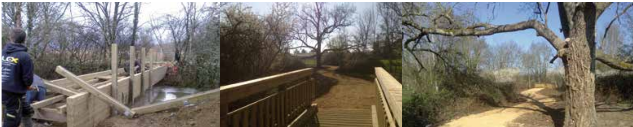
Coulée Verte du Caudeau - Construction d'une passerelle et d'un cheminement pour la connexion au parc de Pombonne.
