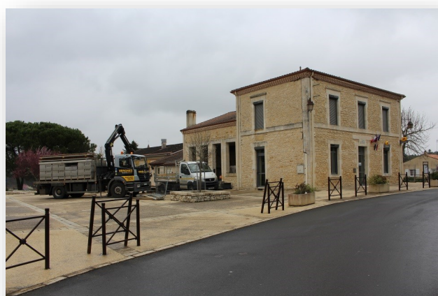
Aménagement du bourg de Ginestet.
