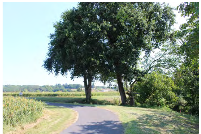
Travaux d'aménagement de la Véloroute Voie Verte rue Armand Got à Bergerac.
