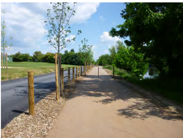
Travaux d'aménagement de la Véloroute Voie Verte rue Armand Got à Bergerac.
