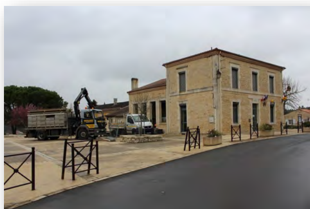
Aménagement du bourg de Ginestet.
