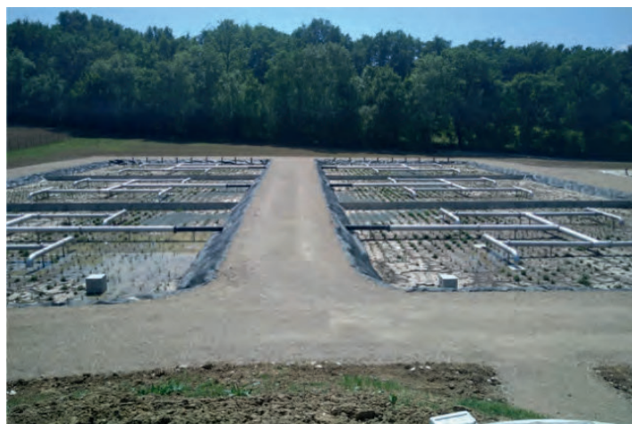
Réhabilitation station épuration Sigoulès-et-Flaugeac
