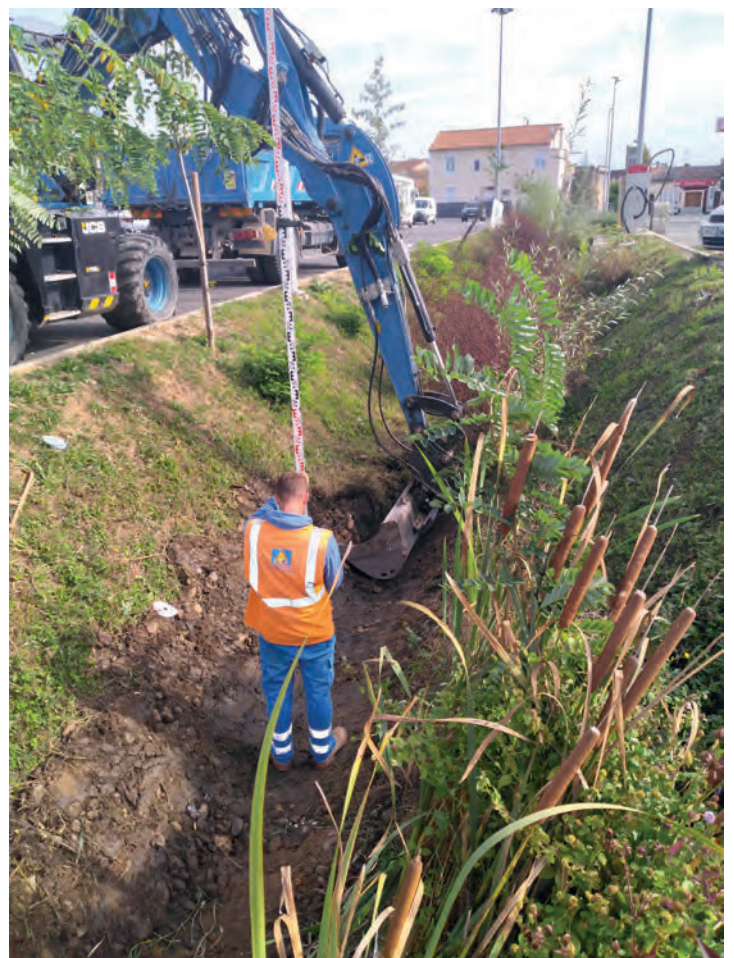
Reprise du profil en long du Cannelet dans le secteur St Martin
