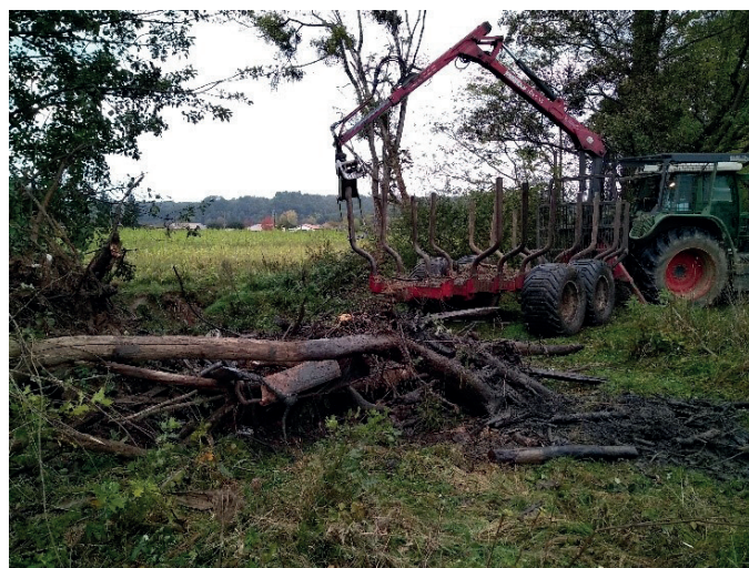
Chantier de désencombrement de la Gouyne
