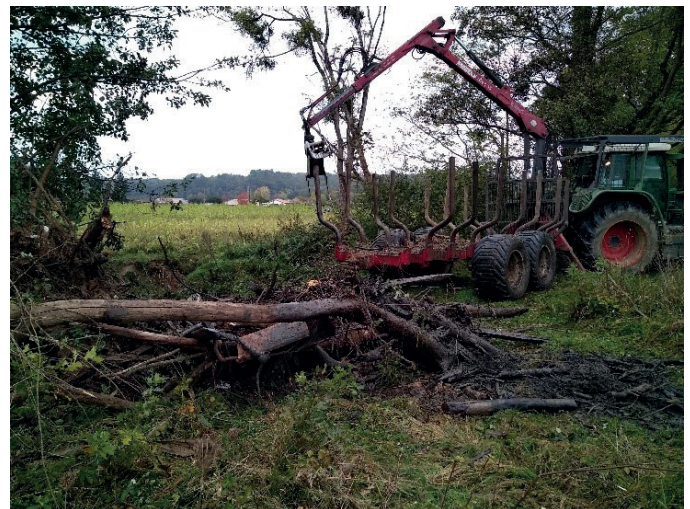
Chantier de désencombrement de la Gouyne
