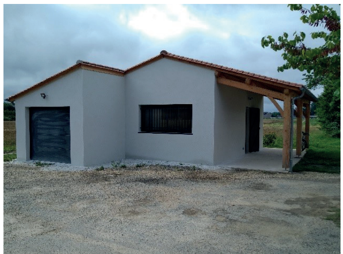
Réhabilitation du garage attenant à la maison blanche pour stockage, préparation et réparation du matériel informatique
