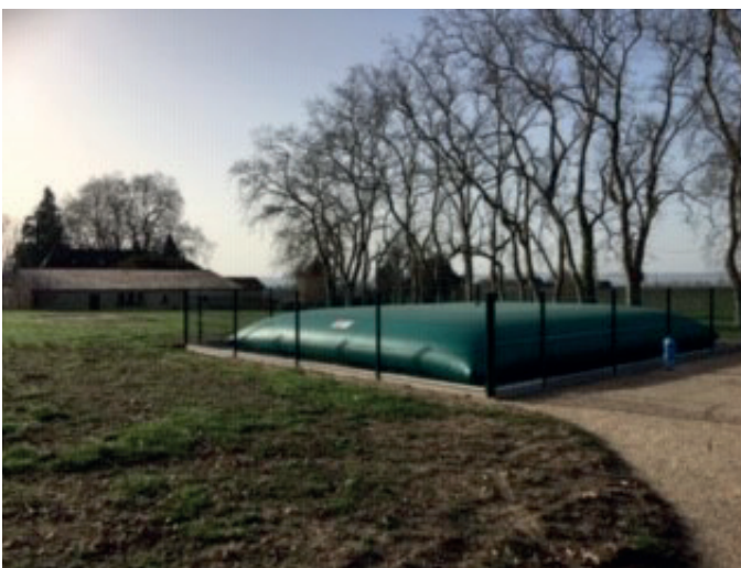
Château du Roc : mise en place d'une bâche à eau (réserve d'eau pour la lutte contre l'incendie)
