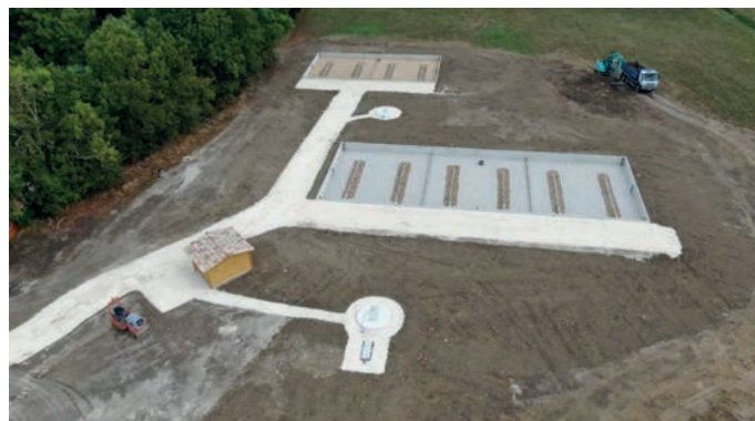
Création Station épuration Cunèges
