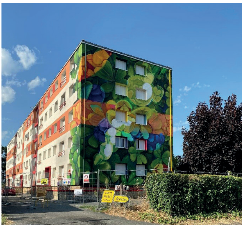
Rénovation de la façade en 2020
