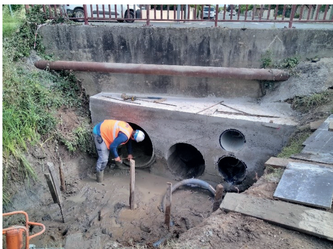
Pose des clapets au Tounet
