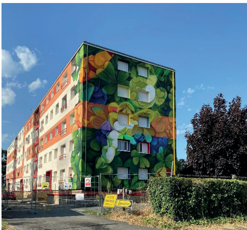
Rénovation de la façade en 2020
