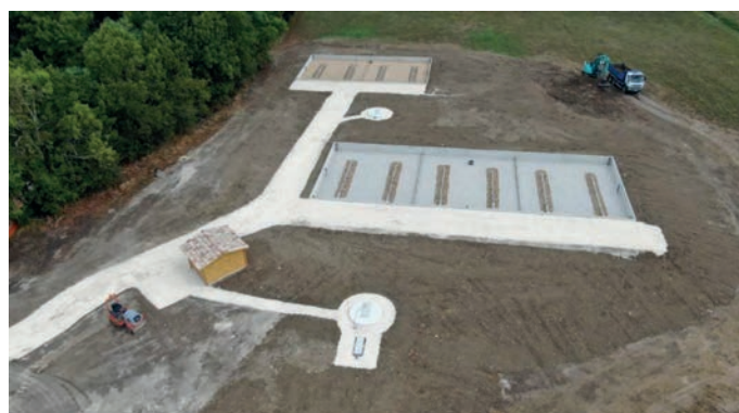
Création Station épuration Cunèges
