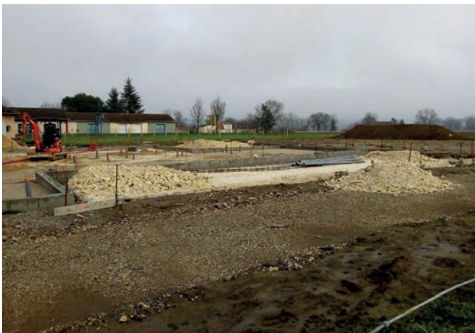
Construction et aménagement de l'ALSH de Cours de Pile
