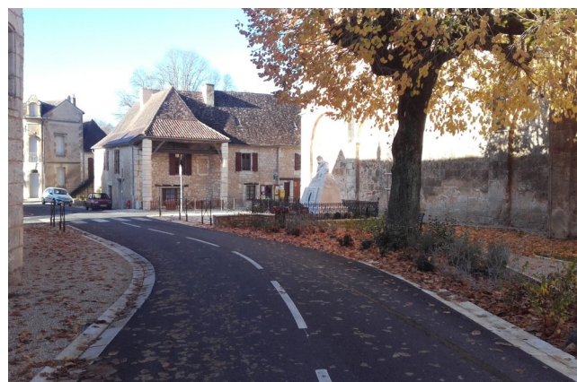
Aménagements de bourg : Lamonzie Montastruc
