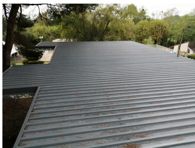
Réfection des toits de l'accueil de loisirs de Toutifaut.
