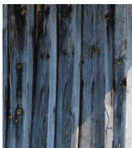
Le Fleix - Bardage à couvre-joint
