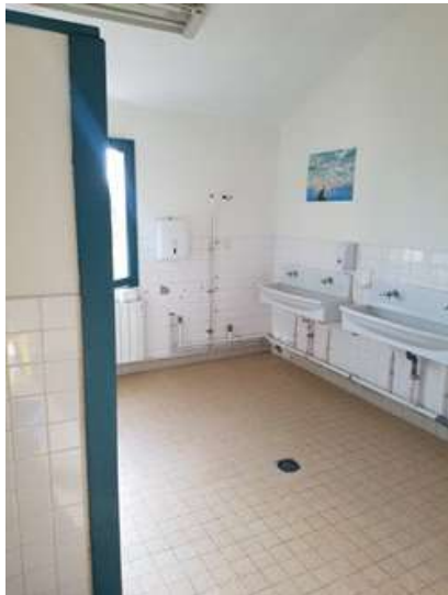
Sanitaires murs et plafonds
