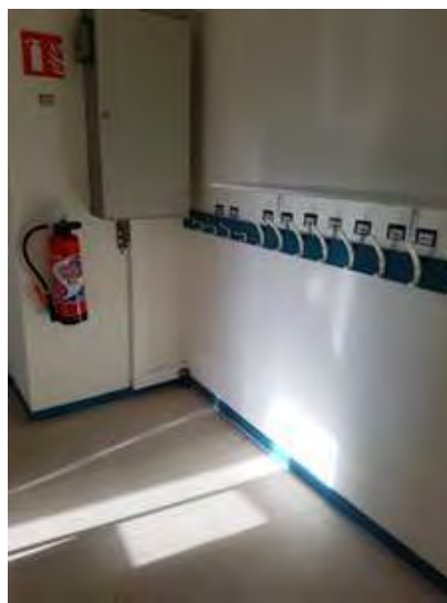
Vestiaires refait du sol au plafond
