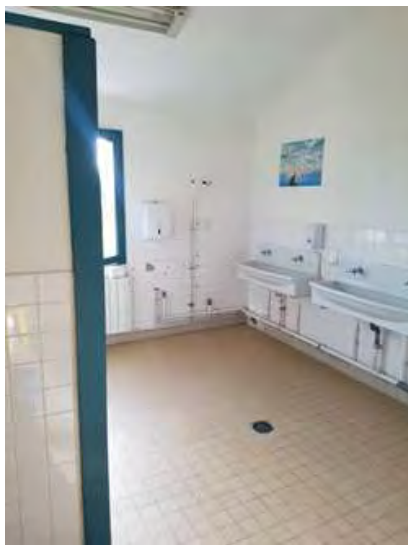
Sanitaires murs et plafonds
