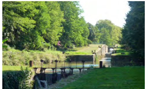
4. Canal de Lalinde et ses écluses
