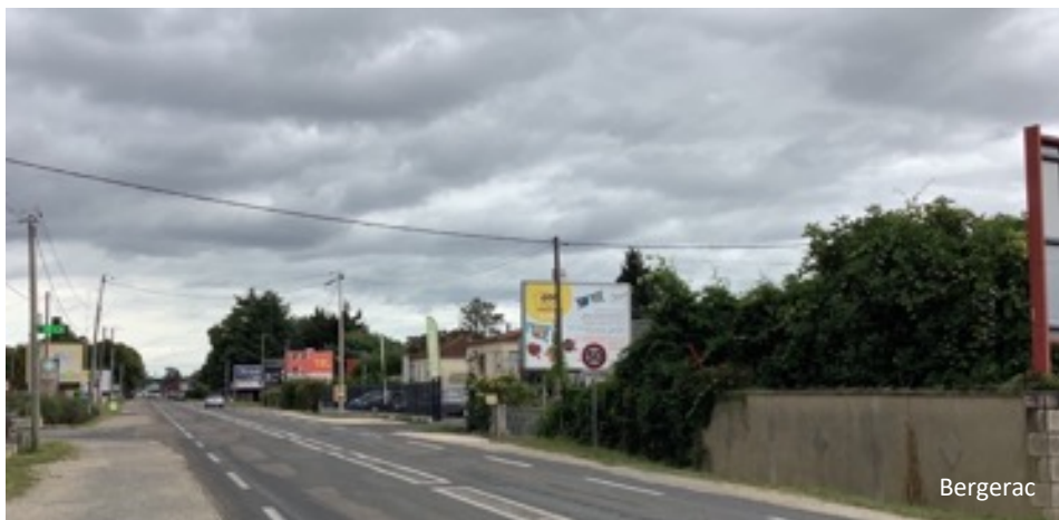
Accumulation de supports scellés au sol ou installés directement sur le sol, Communauté d'Agglomération Bergeracoise, juillet 2021.
